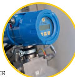
Sensor de vazão Coriolis
